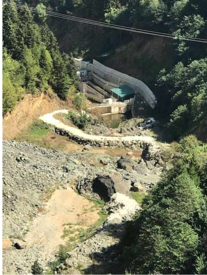
Şekil 4. Karakaya Regülatörü ve HES Projesinin tersip bendi ve önünde biriken malzeme (Tersip bendi üzerinden patika beton kaplı yol geçen yapıdır).
