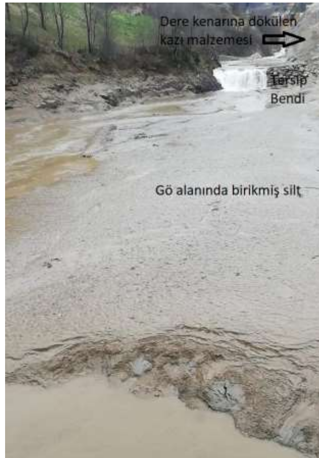
Şekil 2. Tersip bendini aşarak göl alanında biriken silt (Regülatörün üstünden akış yukarı bakış).
