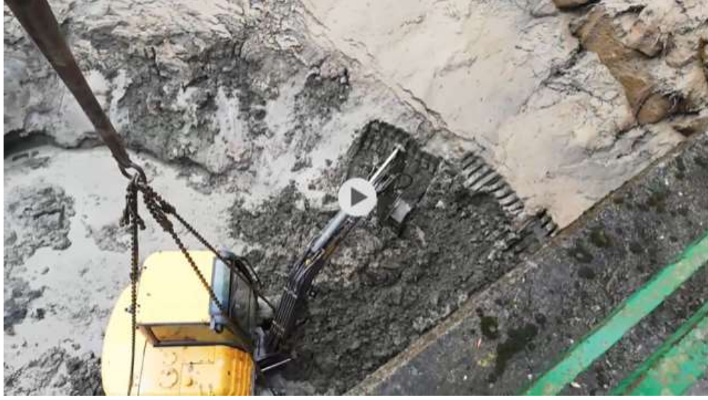
Şekil 3. Mavi Regülatörü rezervuarından silt boşaltma işlemi.
